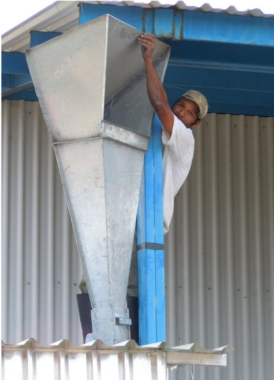
El vínculo de internet usa modems 3G proveídos por compañías telefónicas locales usadas en conjunto con antenas de bocina construidas por Cafés Sustentables de México. El aumento de la directividad obtenida por las antenas de bocina disminuyen interferencia de multicamino y aumenta la fortaleza de señal, por lo que esto aumenta el volumen de datos transferidos a niveles utilizables.
